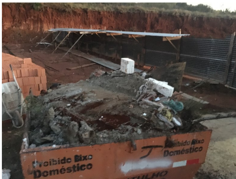
Figura 9 - Acondicionamento final de RCC
