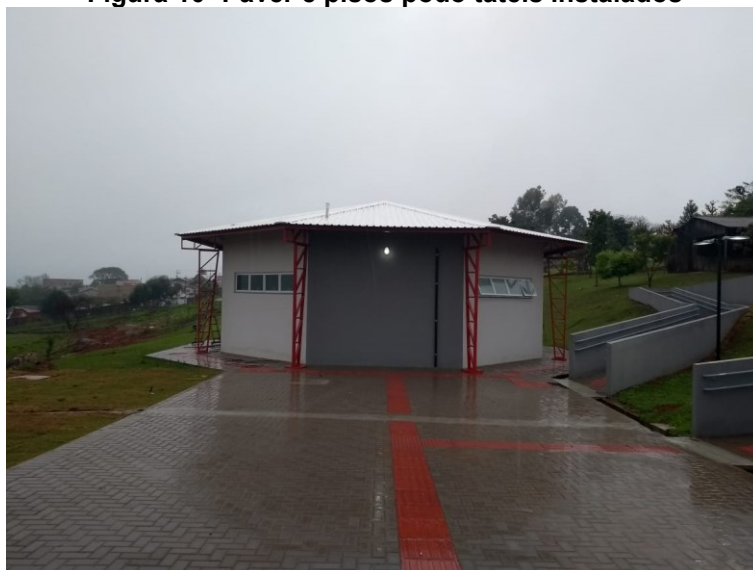
Figura 10- Paver e pisos podotáteis instalados
