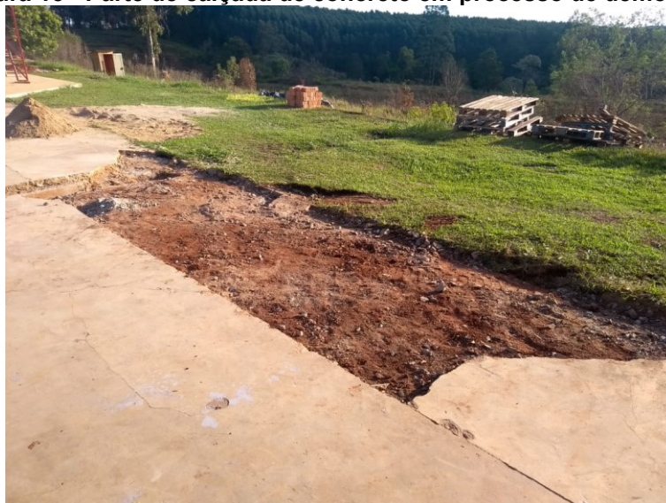
Figura 15 - Parte de calçada de concreto em processo de demolição
