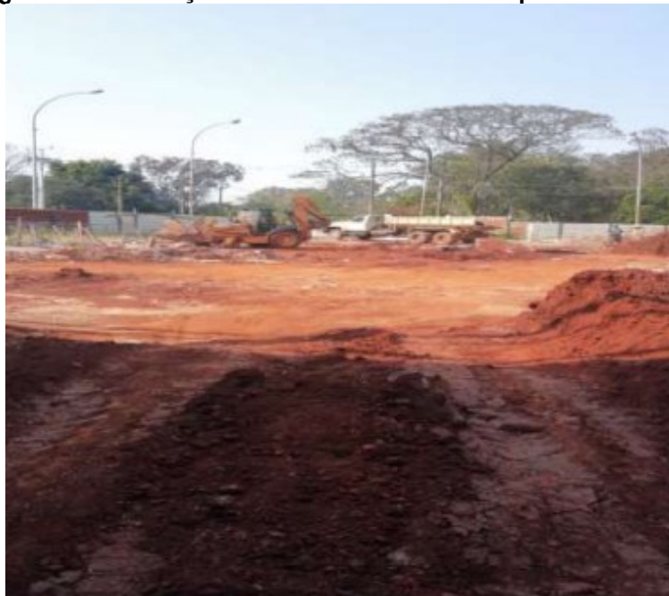
Figura 12 - Demolição e retirada de resíduos de piso de concreto
