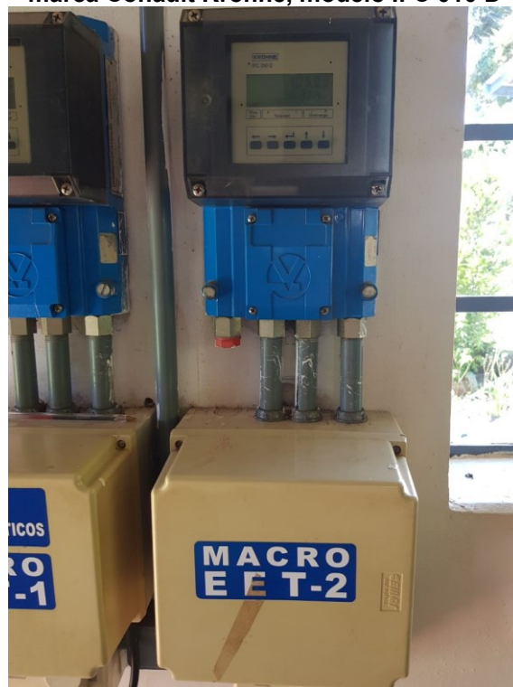
Figura 18 - Macromedidor na EET – 02 da marca Conault Krohne, modelo IFC 010 D
