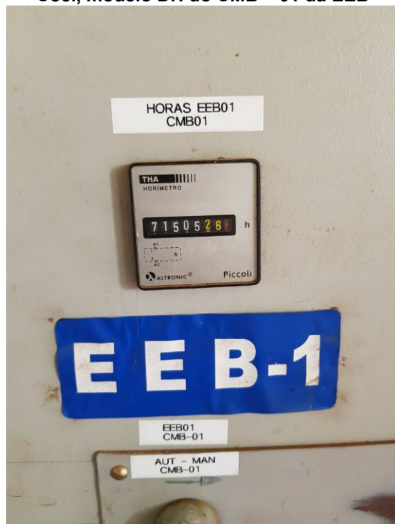
Figura 19 - Totalizador de horas da marca Coel, modelo DH do CMB – 01 da EEB
