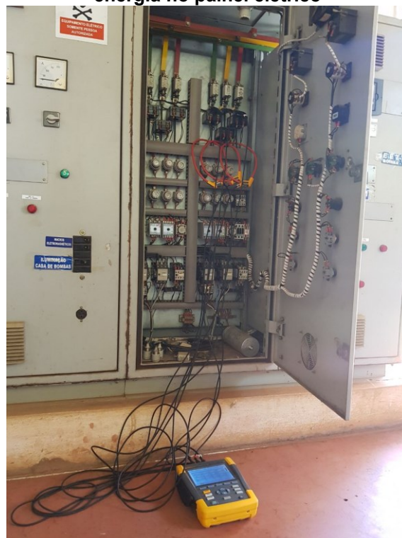
Figura 16 - Instalação do analisador de energia no painel elétrico
