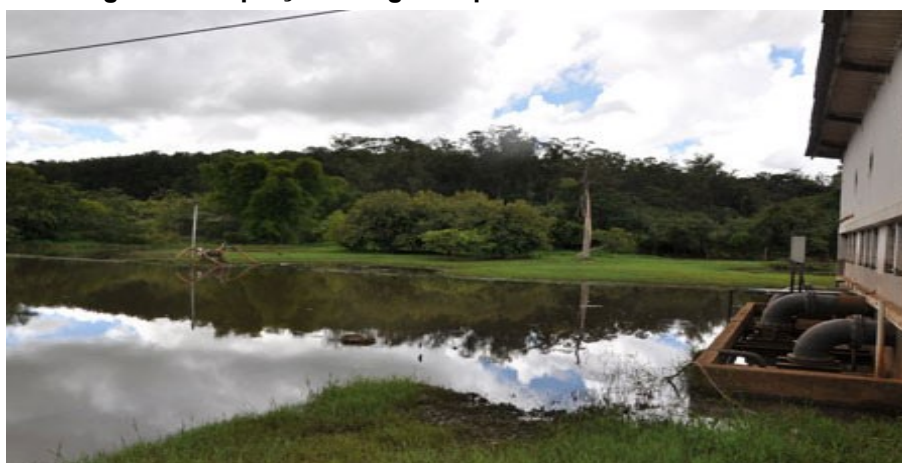
Figura 2 - Captação de água superficial da SAAE São Carlos
