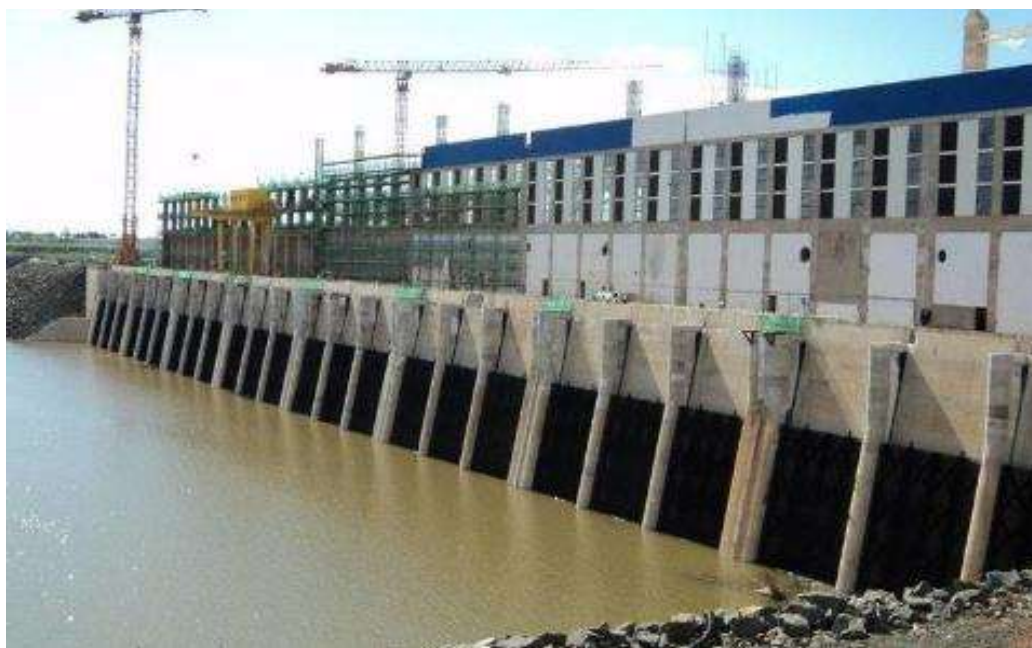
Figura 14 – Sistema de tomada d'água
