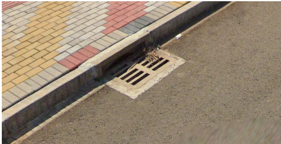
Figura 11 – Existência de rede de drenagem (item 7)
