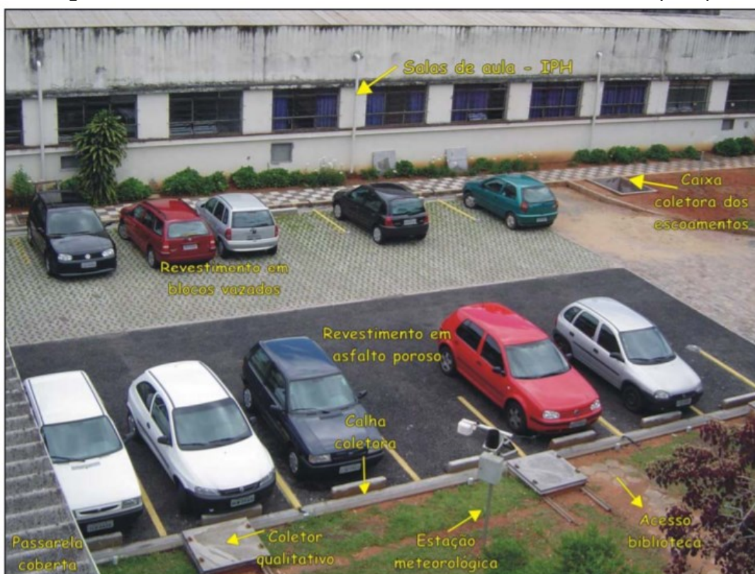
Figura 11 – Estacionamento com Pavimentos Permeáveis de Acioli (2005).
