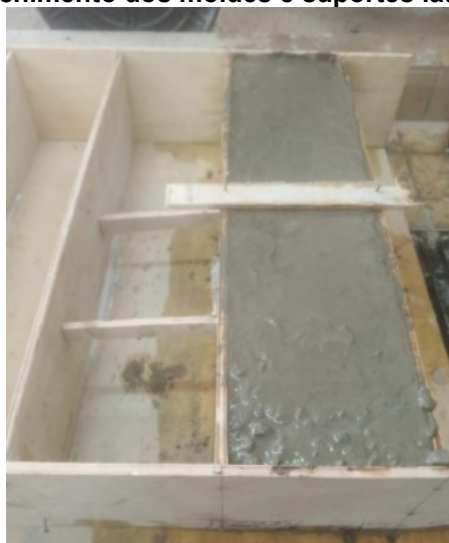
Figura 16 - Preenchimento dos moldes e suportes laterais e superiores
