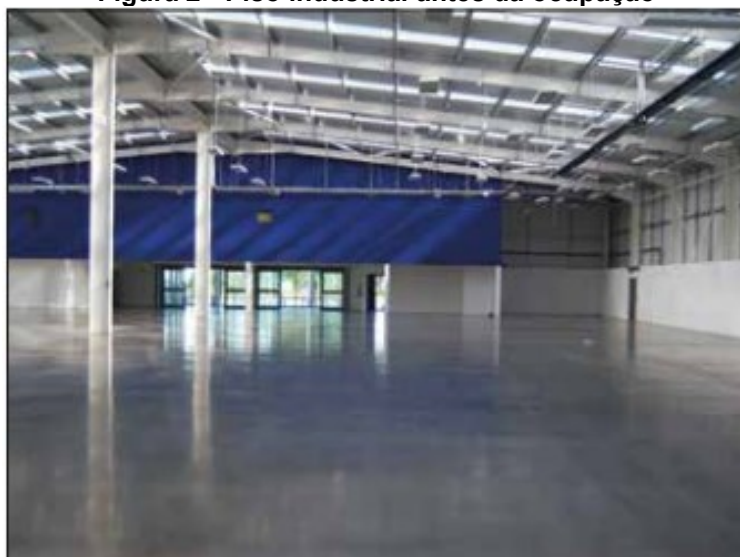
Figura 2 - Piso industrial antes da ocupação
