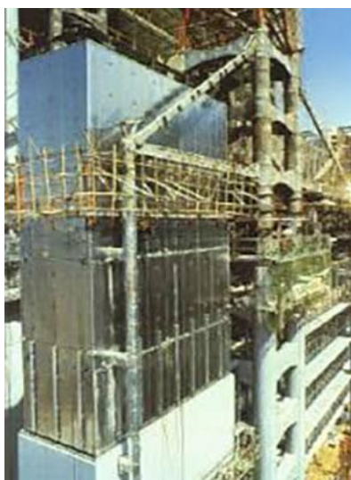
Figura 1 - Unidades modulares utilizadas em uma construção
