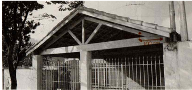
Figura 42: Telhado com a estrutura de Tesoura.
