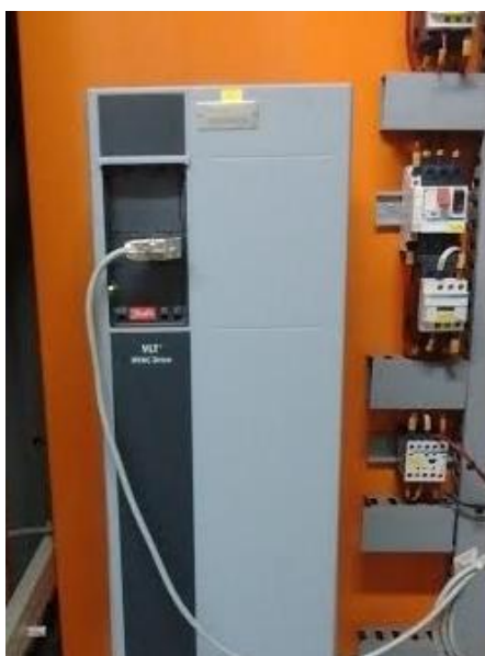
Figura 19 - Painel por dentro Fonte: Aatoria Própria
