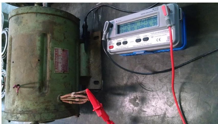
Figura 14 - Medição em motores do laboratório de manutenção
