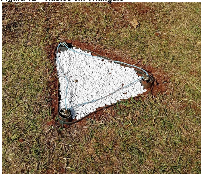
Figura 12 – Hastes em Triângulo
