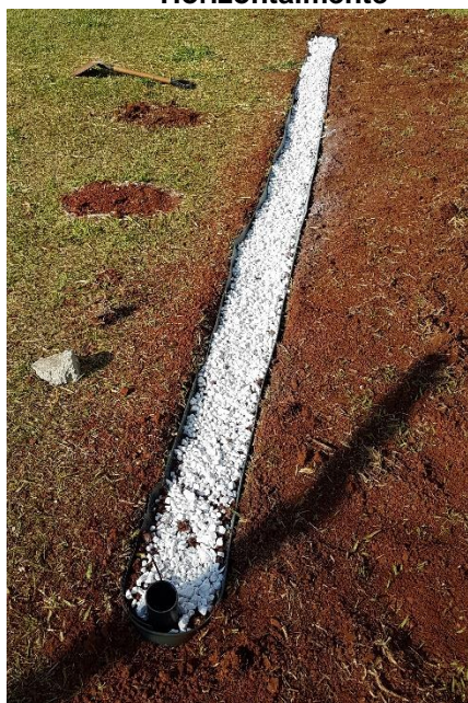
Figura 13 – Condutor Enterrado Horizontalmente
