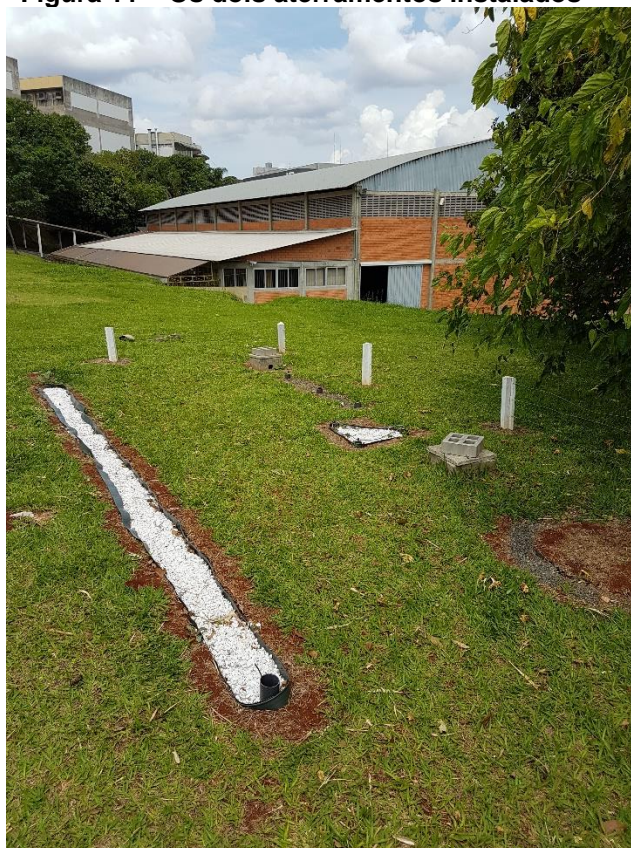
Figura 11 – Os dois aterramentos instalados
