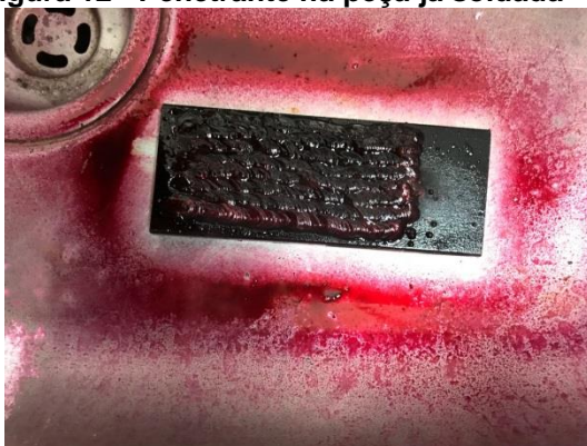
Figura 12 - Penetrante na peça já soldada
