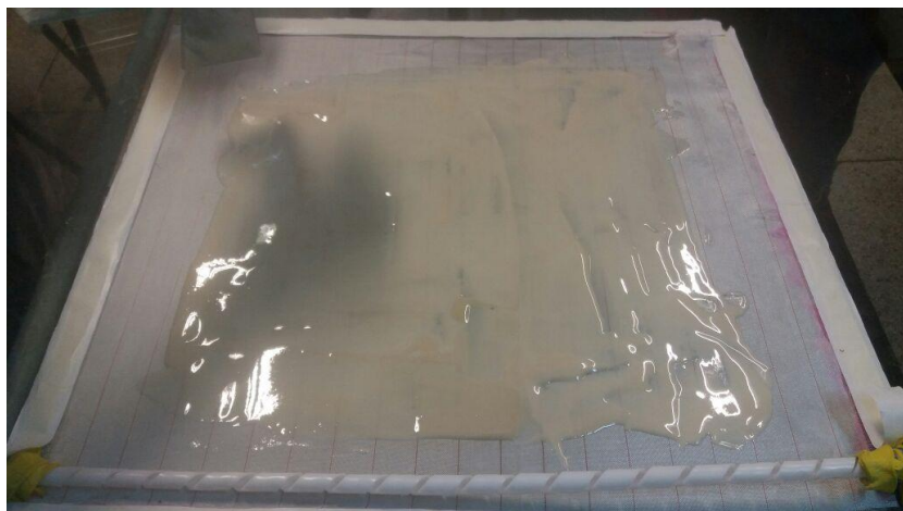
Figura 9: Primeira camada de Poliuretano.
