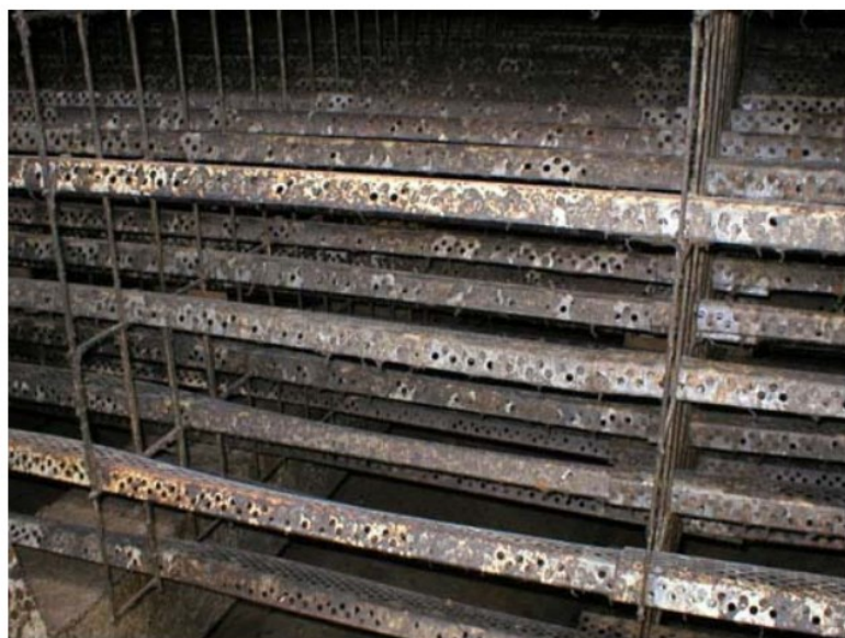
Figura 10 – Enchimento de uma torre de resfriamento com o desenvolvimento de biofilme
