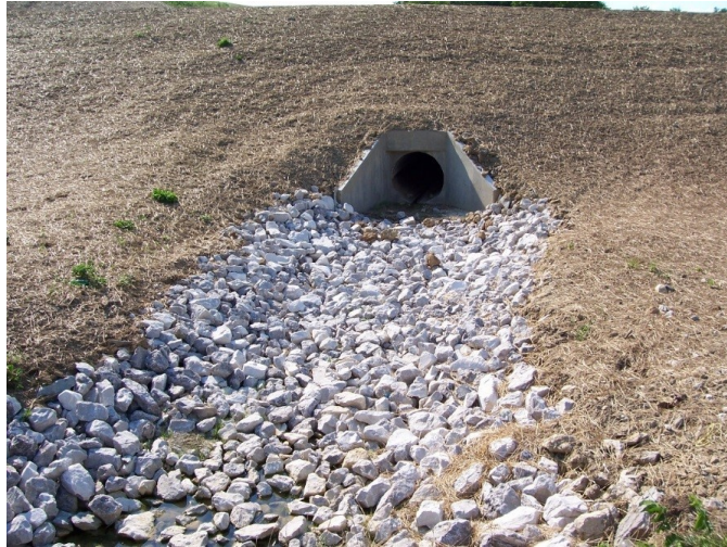
Figura 20 - Plataforma com enrocamento
