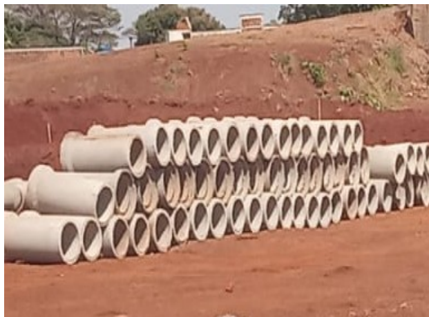
Figura 15 - Manilhas de concreto para drenagem
