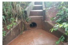
Emissário com plataforma em concreto
