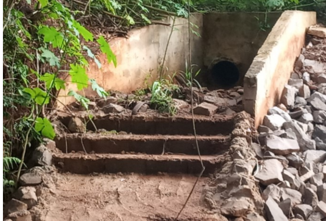
Figura 25 - Escada hidráulica de pequeno porte
