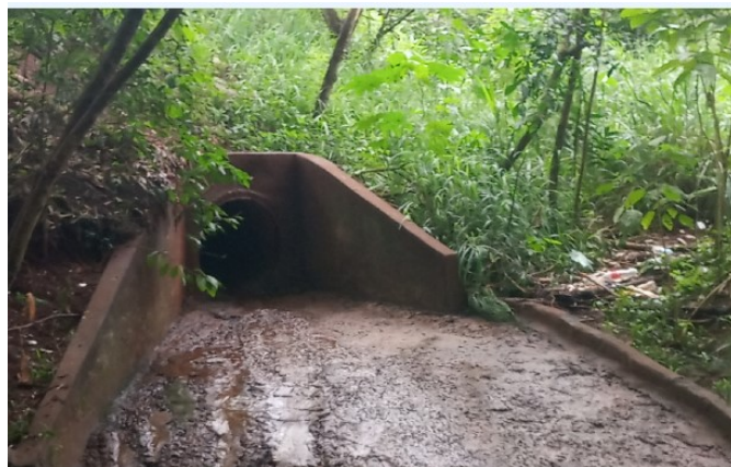
Figura 19 - Plataforma concretada
