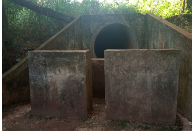
Figura 23 - Blocos de impacto no emissário de lançamento
