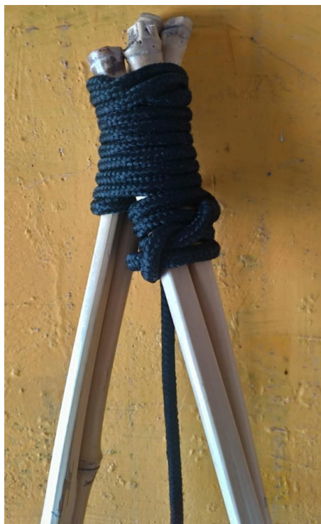
Figura 5B: Fixação da ponta superior.
