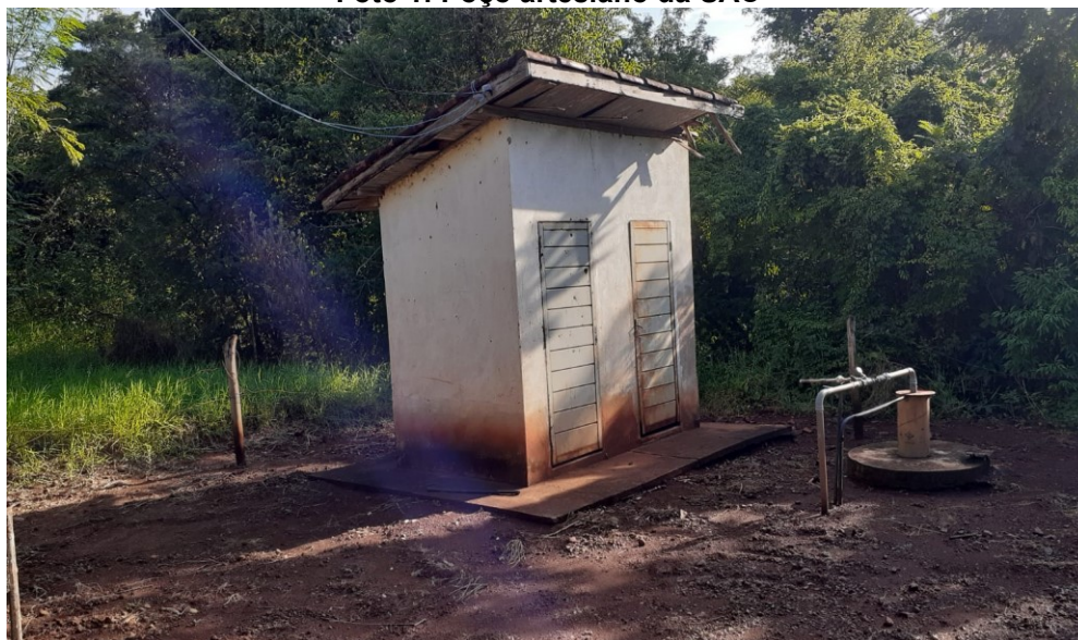
Foto 1: Poço artesiano da SAC
