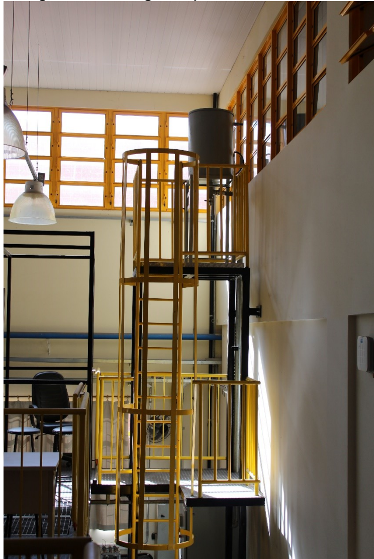
Fotografia 5 - Montagem superior com vista mezanino
