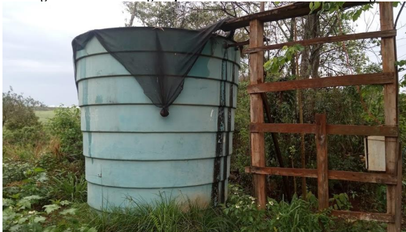
Fotografia 6:Caixa de água que abastece a Escola Itinerante Vagner Lopes
