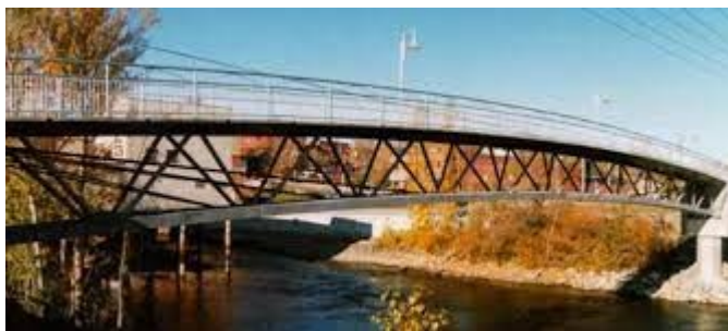
Figura 2 - Passarela de Sherbrooke, Canadá.
