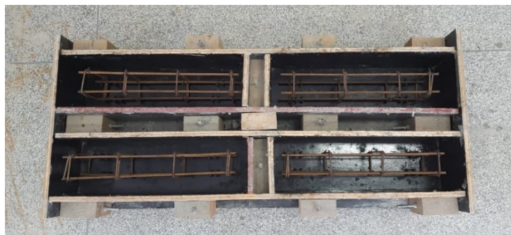
Figura 9 - Armaduras posicionadas nas formas.
