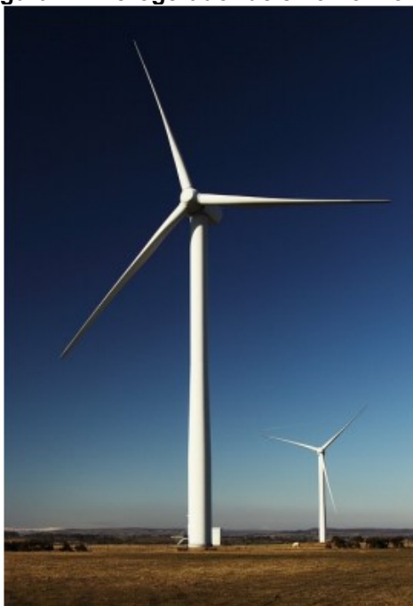
Figura 2 – Aerogerador de eixo horizontal
