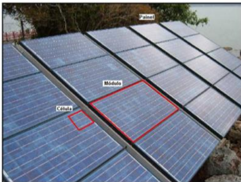
Figura 3 - Vista da célula, módulo e painel fotovoltaico.
