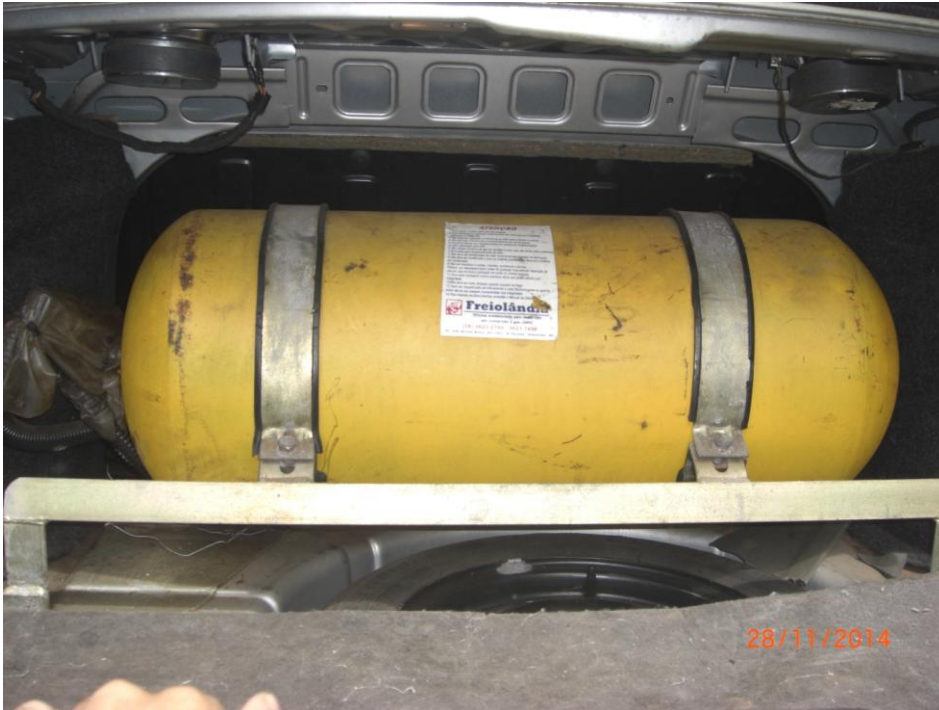
Figura 14: Reservatório de GNV com volume de 61 litros, instalado no porta malas do Verona.
