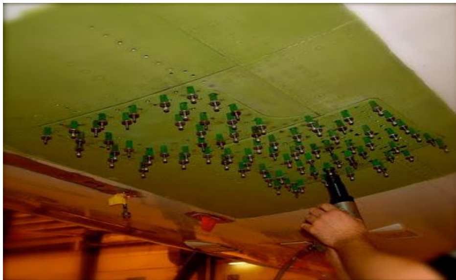
Figura 8 - Reforço estrutural aplicado na fuselagem Fonte: Mecânica de aeronaves, Thiago Winkler (2013)
