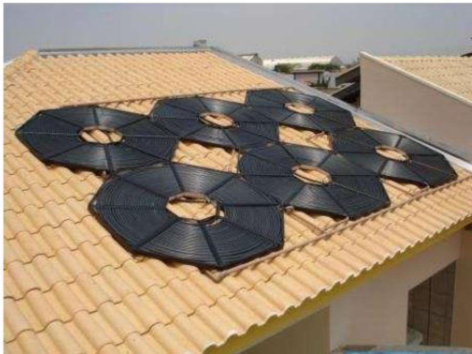
Figura 8 – Coletores solares de mangueira de polietileno dispostos em espirais. Fonte: Gonçalves 2010.
