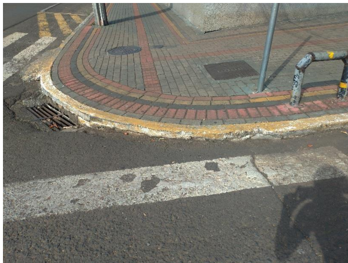
Figura 18 - Não concordância entre a calçada e a travessia de pedestres Fonte: Aatoria Própria, 2021.
