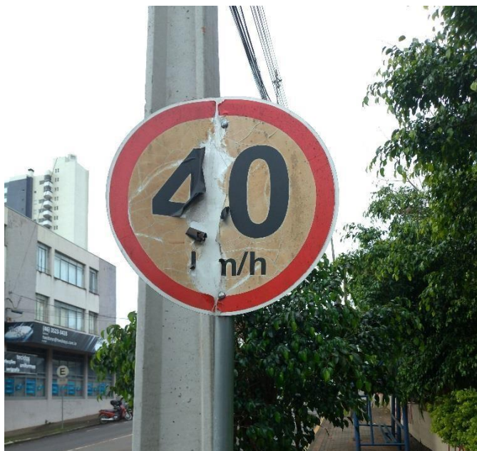
Figura 26 - Sinalização visual desgastada Fonte: Aatoria Própria, 2021.
