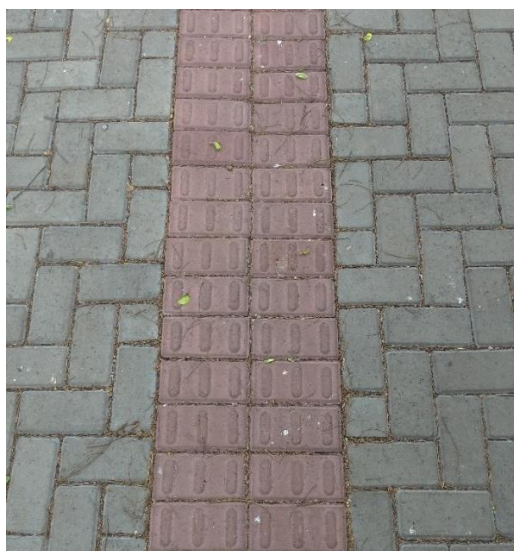
Figura 34 – Blocos podotáteis (duas carreiras) Fonte: Autoria Própria, 2021.
