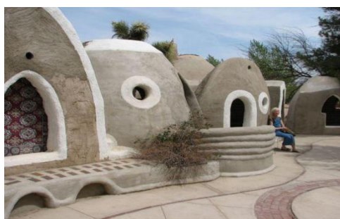
Figura 12 – Casa em superadobe
