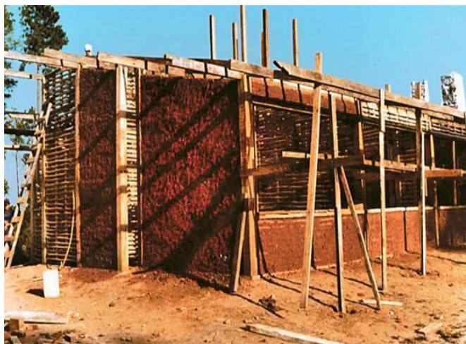
Figura 4 – Prensamento da argamassa de barro na taipa de mão
