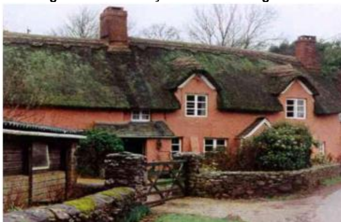
Figura 6 – Construção em Cob na Inglaterra
