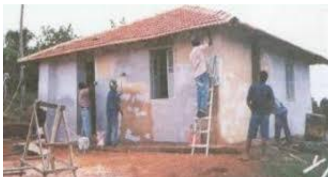
Figura 17 Pintura feita com caiação
