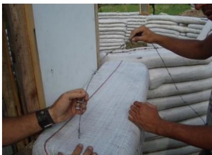
Figura 10 – Arame farpado na construção em superadobe
