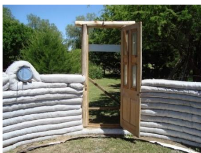
Figura 11 – Colocação de porta na construção em superadobe
