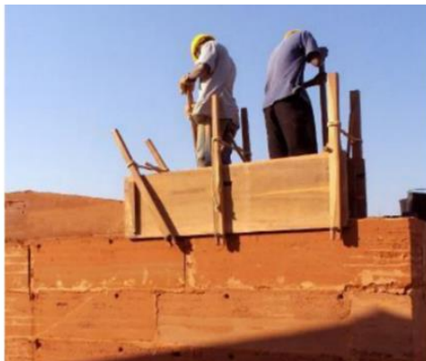
) Figura 14 – Confeção de Taipa de Pilão
