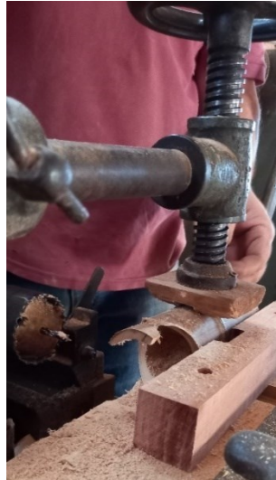
Figura 29 - Execução da boca de peixe no colmo inferior da ligação T
