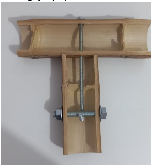
Figura 18 - Ligação perpendicular com barra roscada
