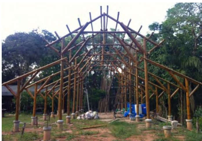
Figura 10 - Pavilhão em Mairiporã/SP
