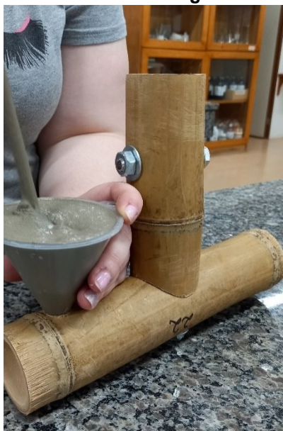
Figura 36 - Preenchimento de argamassa nas ligações
