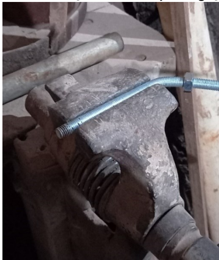
Figura 33 - Execução de dobra para ligação 45°
