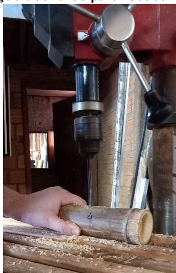
Figura 28 – Execução dos furos para receber as barras roscadas
