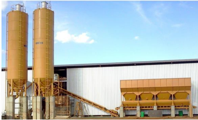
Figura 17: Central de concreto Fonte: Welter Holzberger (2021).
