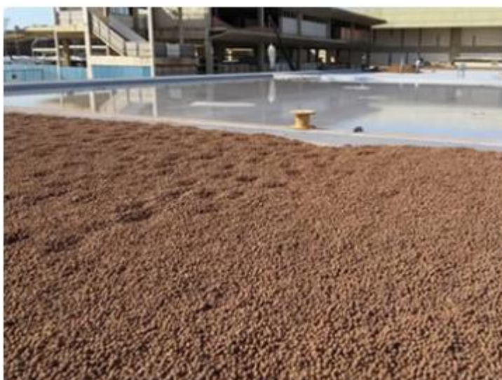
Figura 35: Aplicação de argila expansiva sobre laje Fonte: Cinexpan, 2021.
