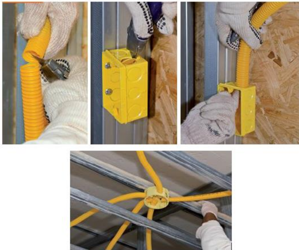
Figura 14: Instalações elétricas em steel frame Fonte: Cichinelli, 2012.
