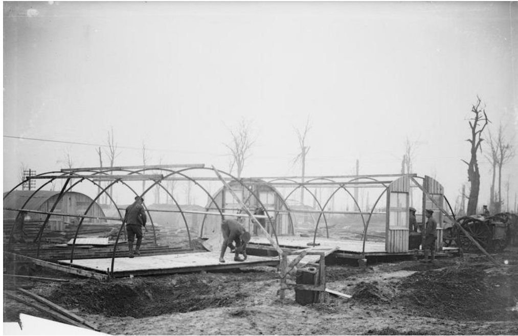
Figura 1 - Tropas britânicas construindo cabanas de Nissen Fonte: Horta, 2021.
