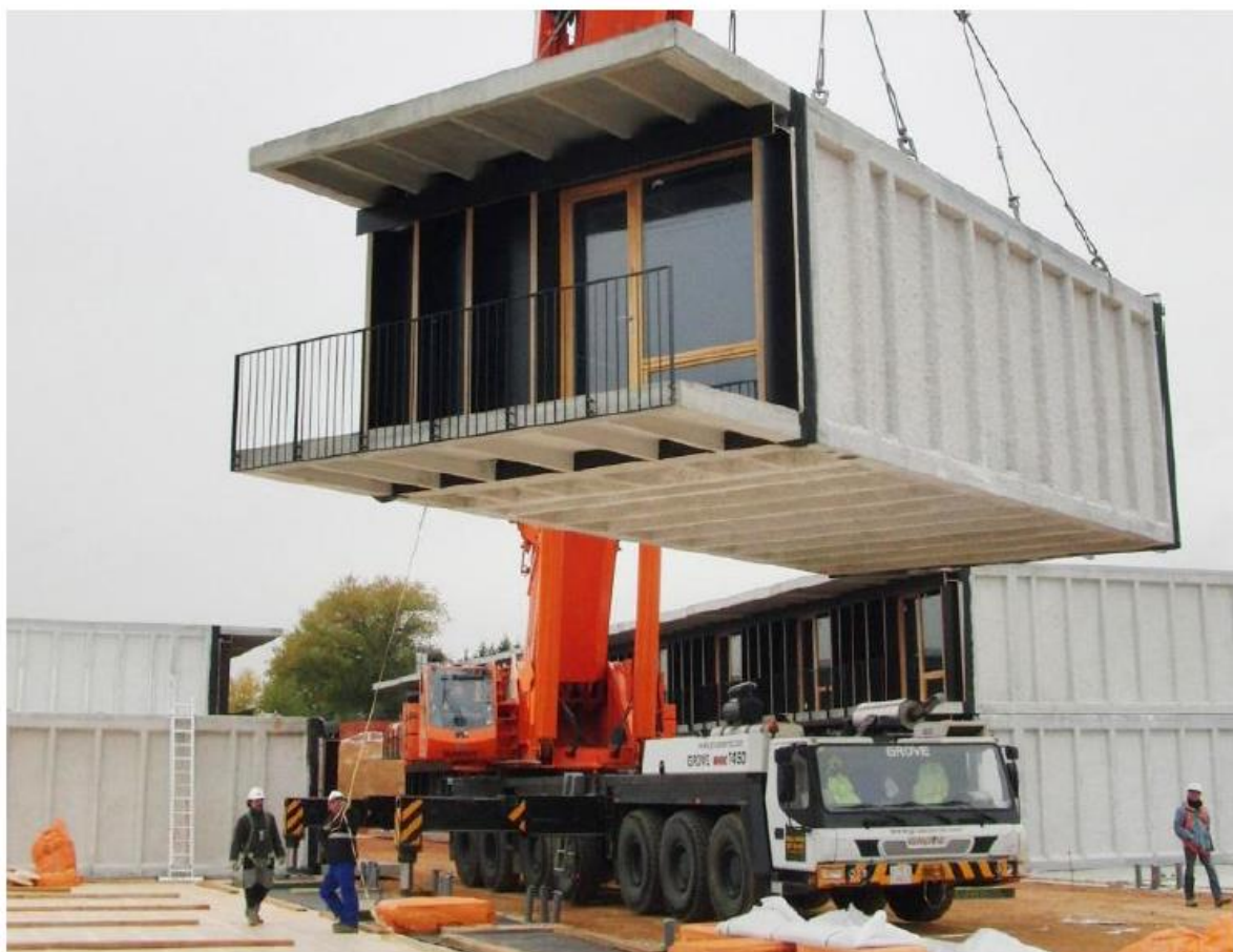
Figura 31: Manuseio de módulo de concreto Fonte: Paulo Oliveira, 2019.
