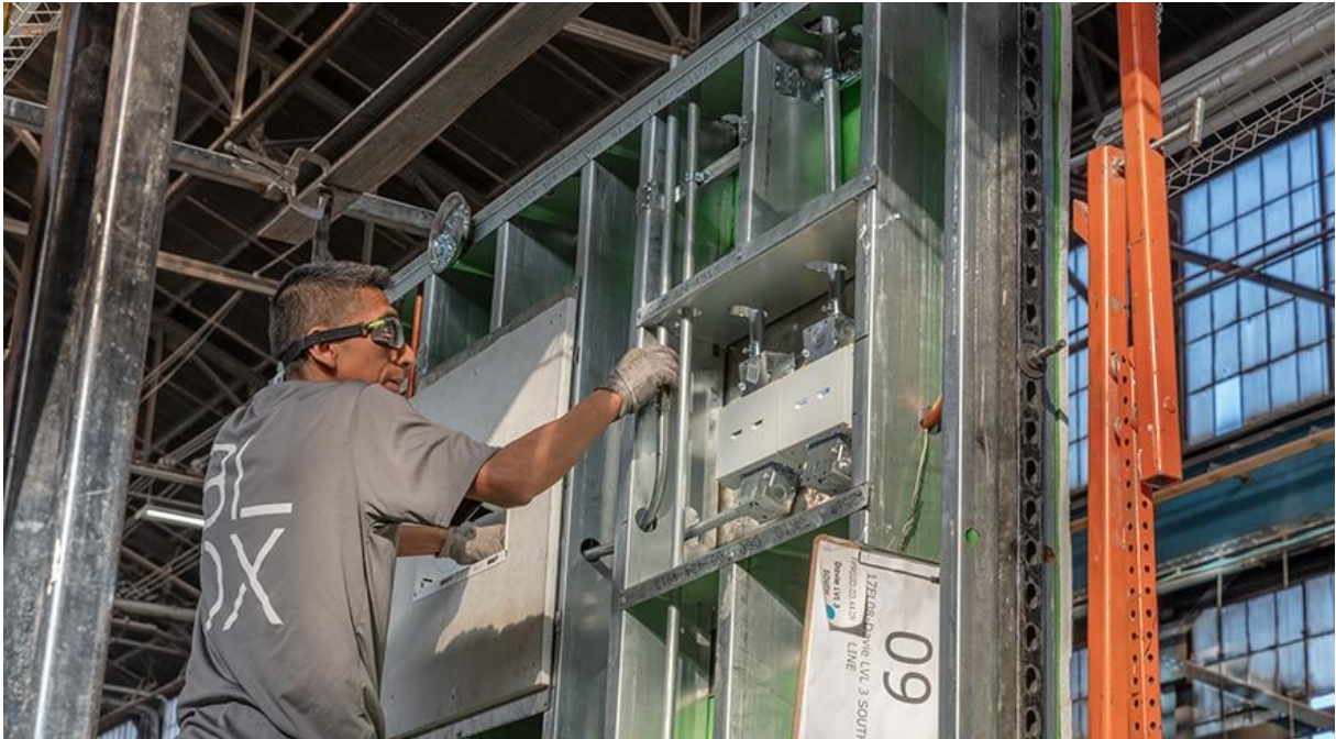
Figura 27: Montagem de componentes das instalações médicas Fonte: Autodesk, 2020.
