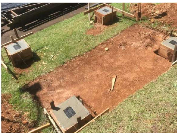
Figura 20: Concretagem das sapatas Fonte: Autoria própria (2021).
