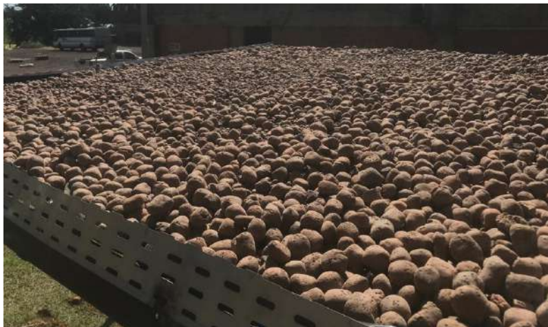
Figura 22: Camada de drenagem Fonte: Autoria própria (2021).
