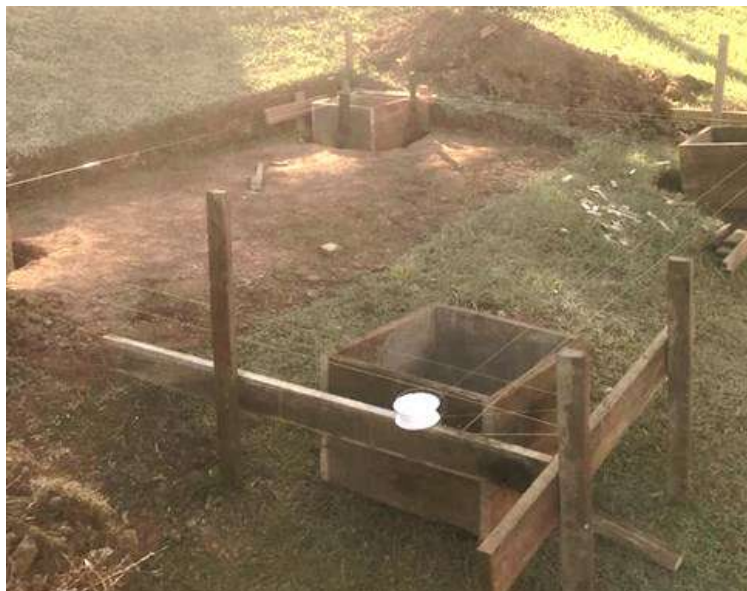
Figura 19: Nivelção do terreno e locação das sapatas Fonte: Autoria própria (2021).
