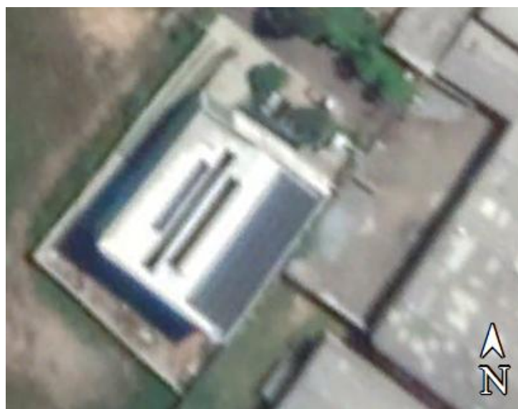
Figura 22: Disposição dos módulos fotovoltaicos sobre o telhado metálico da indústria
