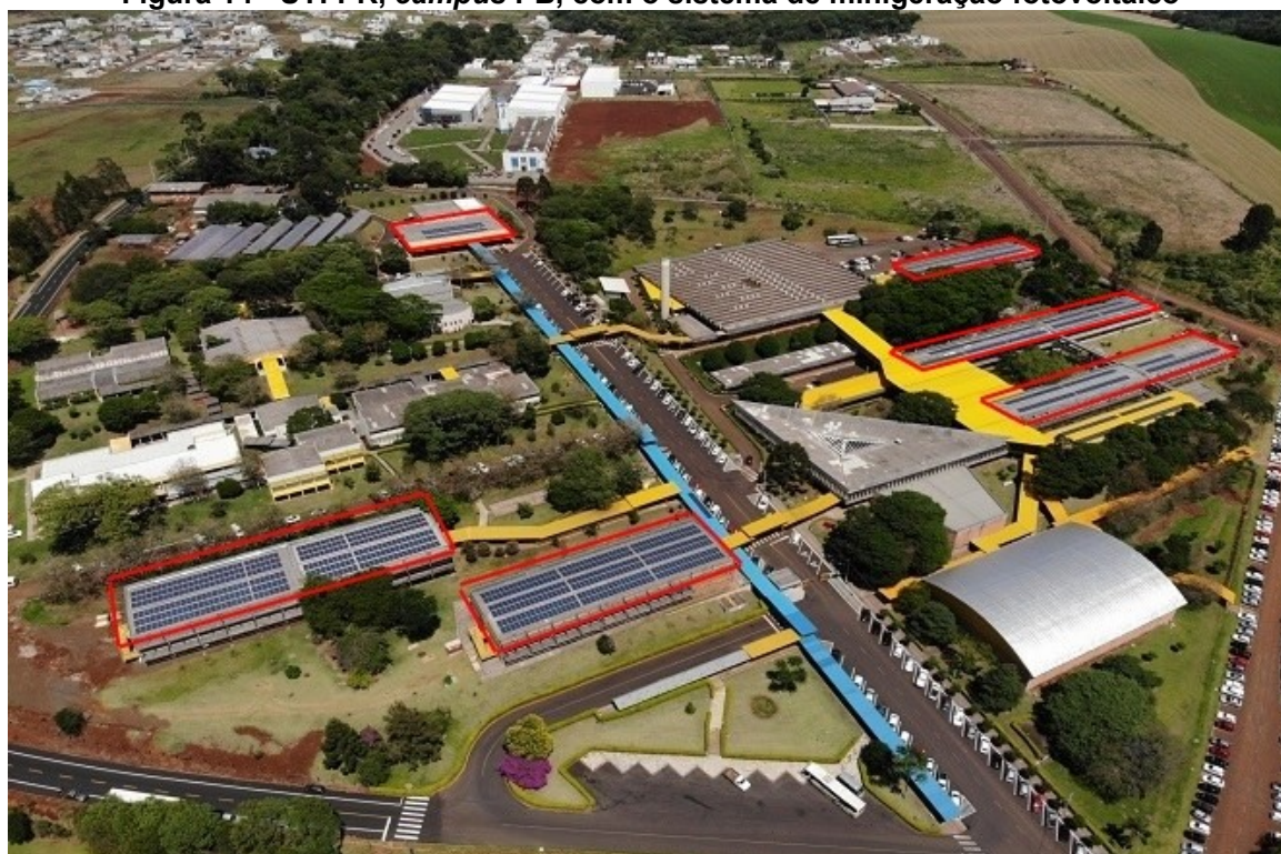
Figura 14 - UTFPR, campus PB, com o sistema de minigeração fotovoltaico
