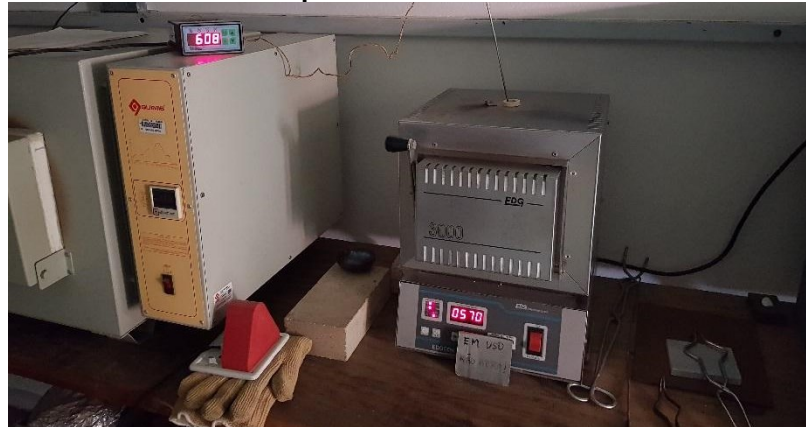
Figura 6 - Forno EDG 3000 para tratamento térmico da fluorita.
