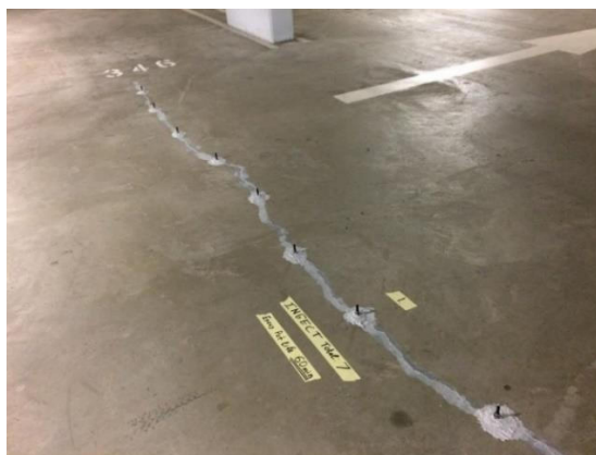
Figura 44 – Injeção de resina epóxi
