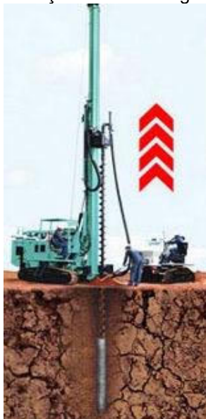
Figura 2 - Ilustração da concretagem da estaca
