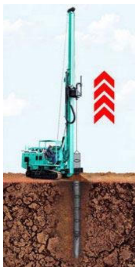
Figura 1 - Ilustração da colocação da armadura da estaca
