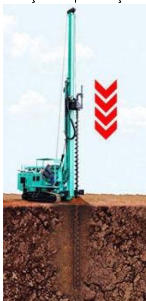
Figura 1 – Ilustração da perfuração da estaca
