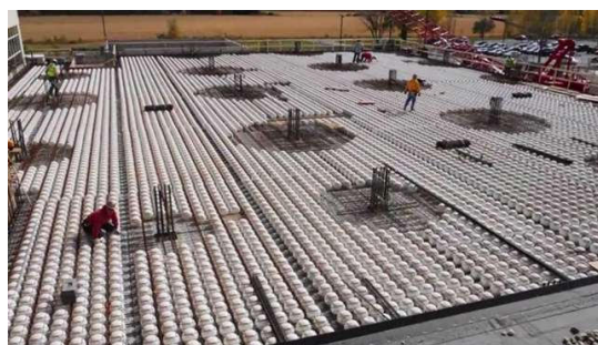
Figura 10 - Região sem esferas nas proximidades do pilar
