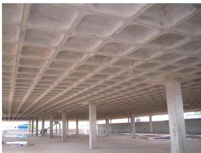
Figura 5 – Aparência da laje nervurada lisa bidirecional concretada usando cubetas plásticas
