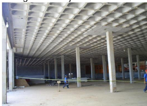
Figura 4 – Laje nervurada lisa
