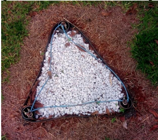
Figura 11 – Aterramento de haste em triângulo.
