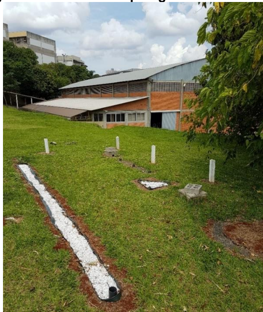
Figura 9 – Diferentes topologias de aterramento.
