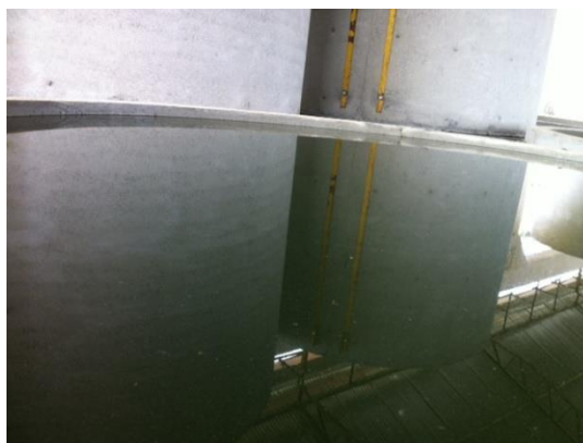
Figura 40 - Teste de estanquidade Fonte: Autora.
