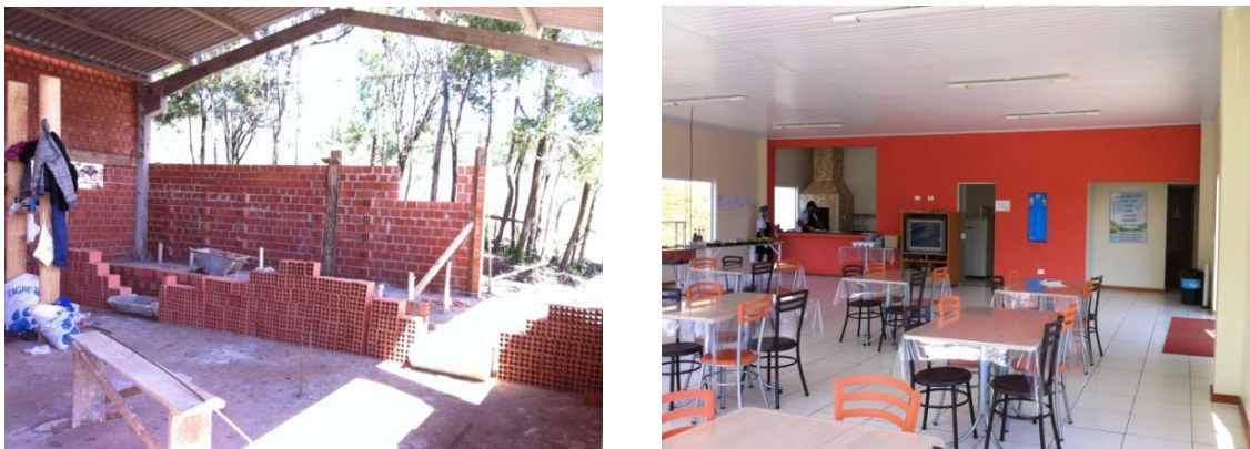
Figura 28 - Ambiente construído para refeitório, sala de treinamentos e entretecimentos. À esquerda o antes e, a direita, atual.
