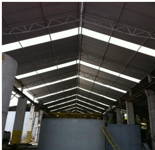
Figura 32 - Cobertura após reforma Fonte: Autora.
