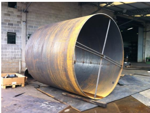
Figura 33 - Fôrma em fabricação Fonte: Autora.
