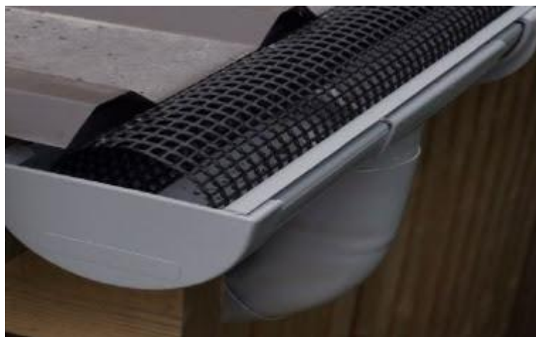
Imagem 01 – Instalação de tela sobre a calha para diminuir a entrada de folhas nos condutores.
