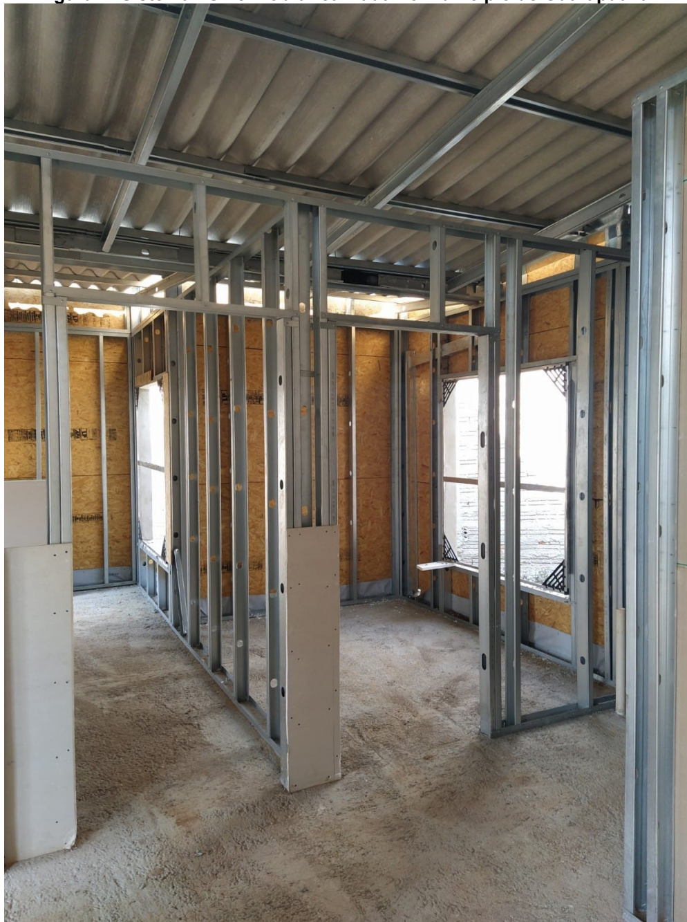
Figura 4: Sistema LSF em obra realizada no município de Guarapuava
