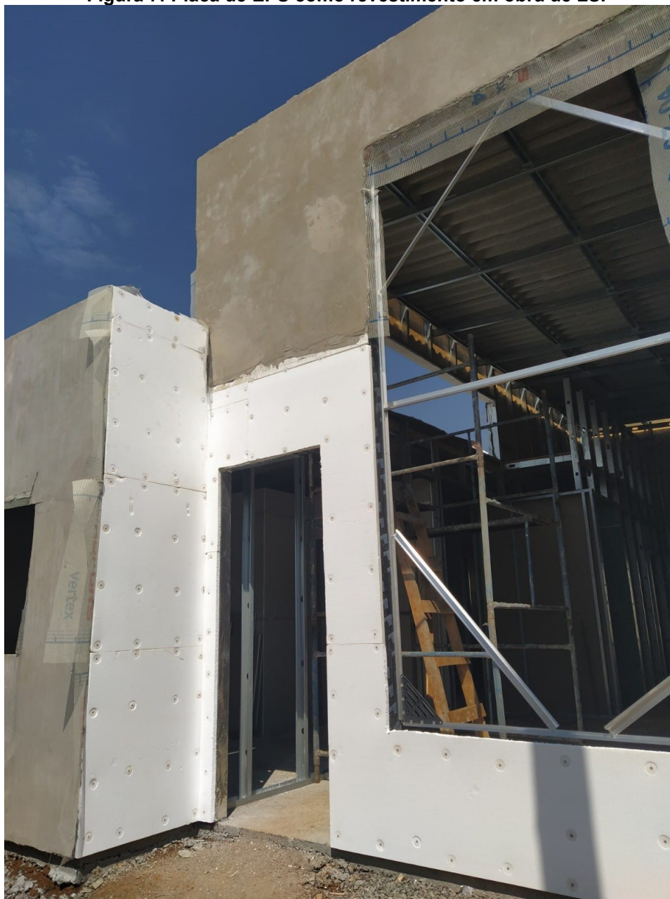
Figura 7: Placa de EPS como revestimento em obra de LSF
