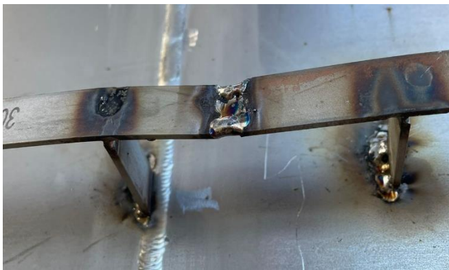
Foto 5: Suporte improvisado para aparato de infraestrutura elétrica, em tubulação de inox, processo TIG.
