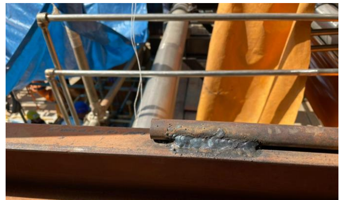
Foto 6: Solda filete em vergalhão e perfil U, em ER.
