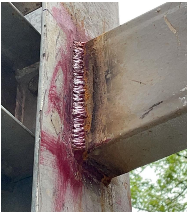
Foto 11: Solda realizada em ER em estrutura de pipe rack de tubulações.
