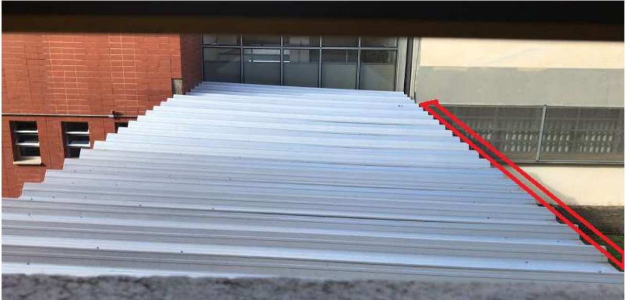
Figura 9. Localização da calha, sobre a cobertura da passarela entre o bloco R e Q
