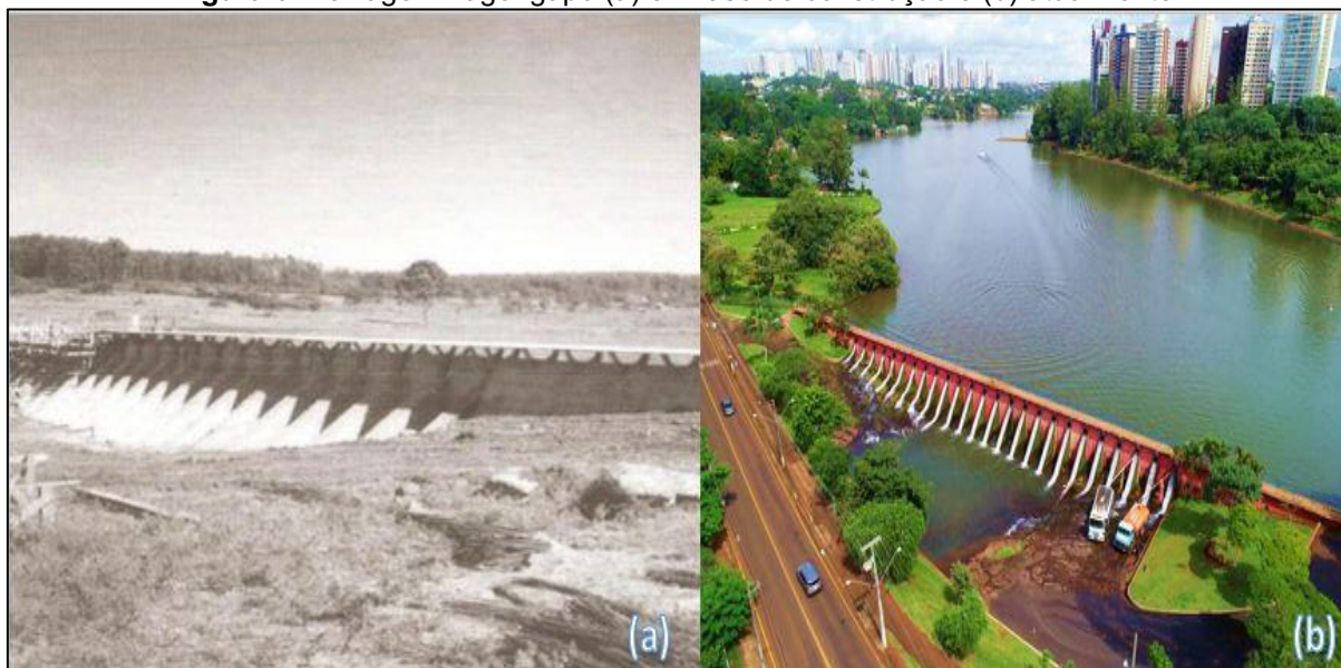
Figura 6: Barragem Lago Igapó (a) em fase de construção e (b) atualmente.
