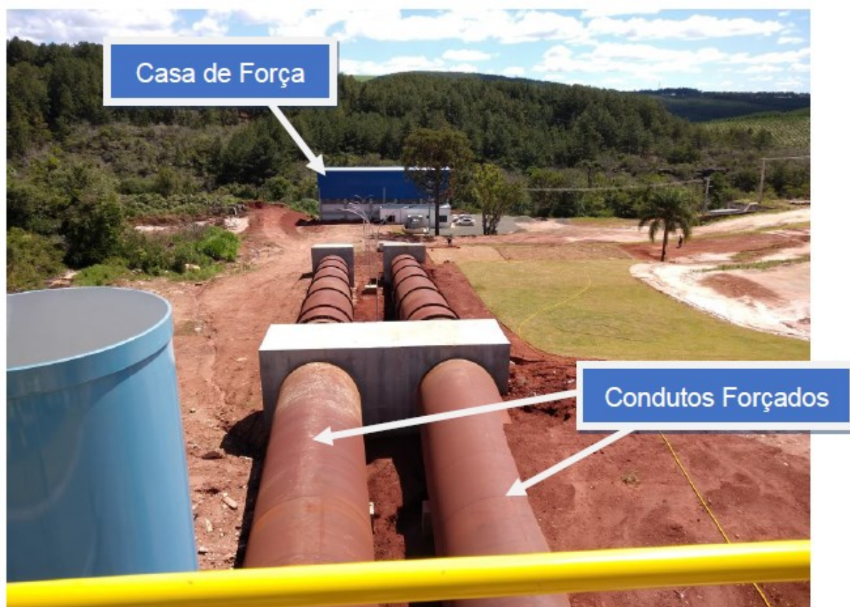
Fotografia 6: Local dos Conduitos Forçados e Casa de Força
