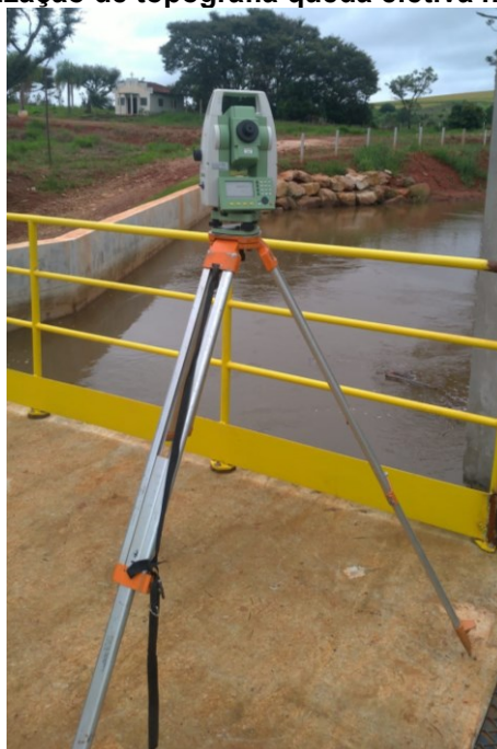
Fotografia 7: Realização de topografia queda efetiva na Câmara de Carga
