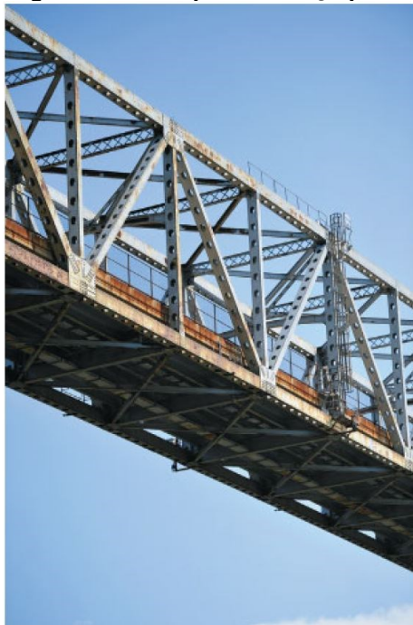
Figura 1 – Exemplo de treliça planar
