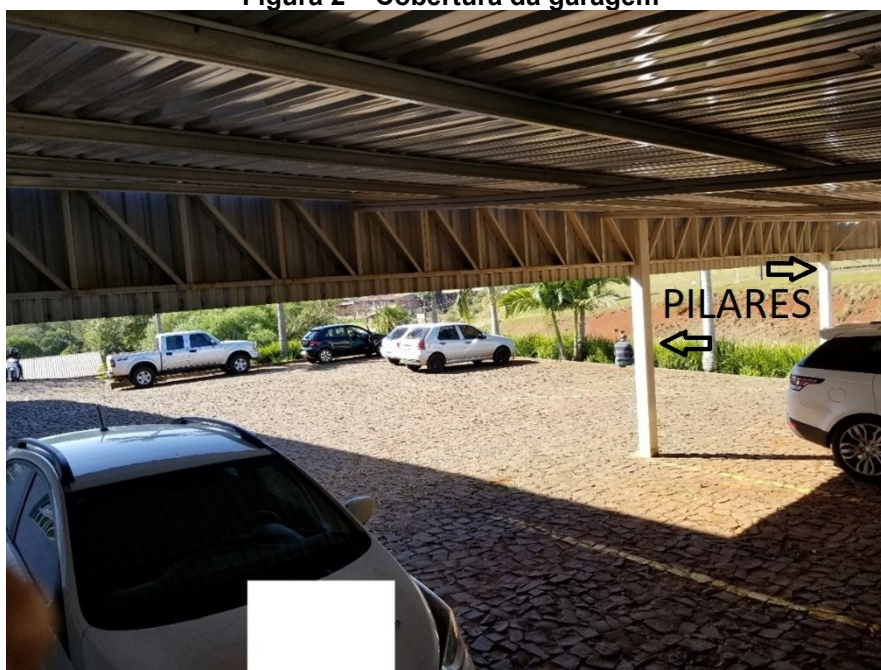
Figura 2 – Cobertura da garagem
