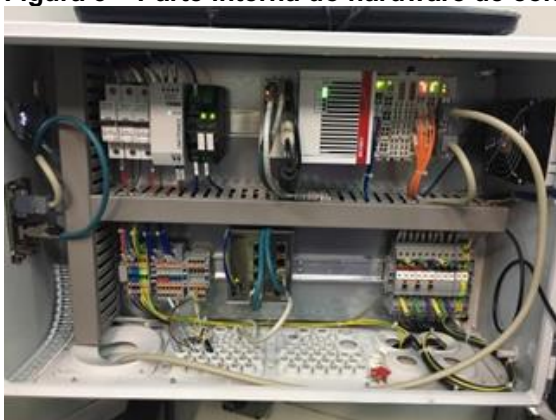
Figura 3 – Parte interna do hardware de coleta de dados
