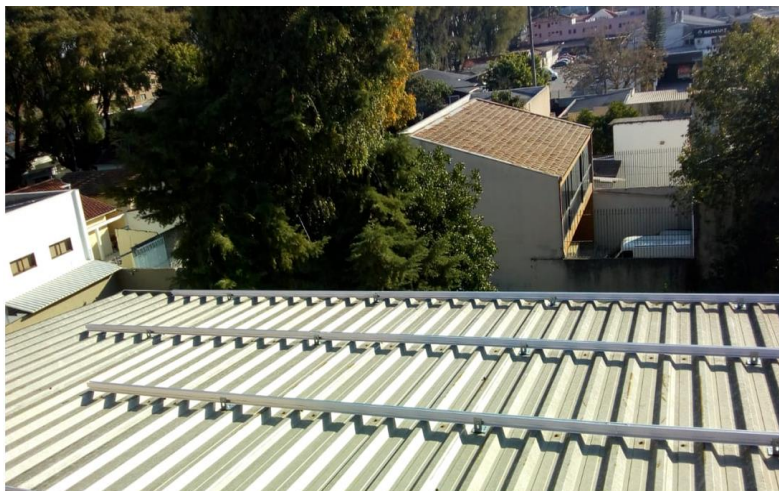
Figura 50 - Suporte de fixação para telhado metálico
