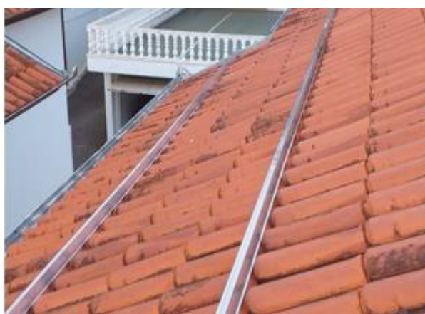
Figura 59 - Imagem do detalhe do trilho de fixação
