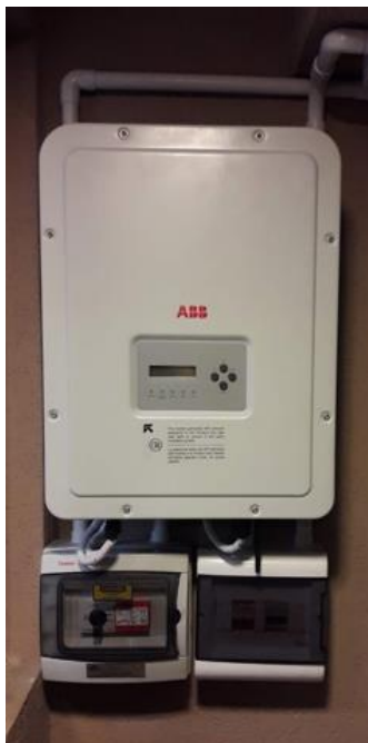
Figura 17 - Inversor ABB UNO - DM-3.3-TL-PLUS-SB
