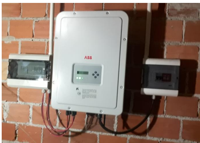
Figura 66 - Inversor ABB UNO-DM-4.6-TL-PLUS-SB
