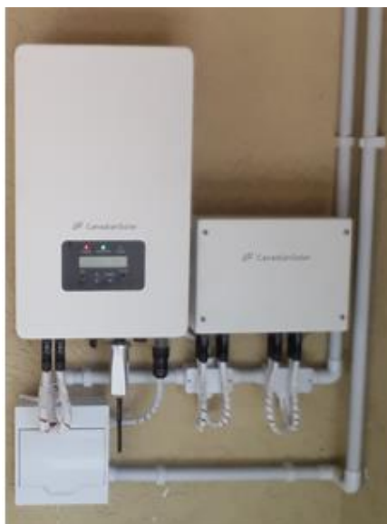
Figura 34 - Inversor CANADIAN CSI-5KTL1P-GI-FL - Sistema 3
