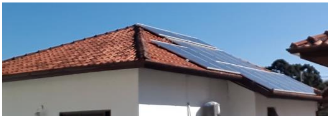
Figura 60 - Imagem da instalação dos módulos fotovoltaicos
