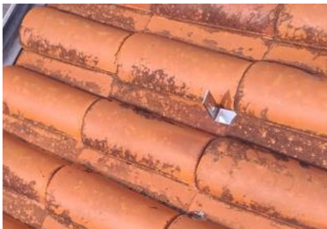
Figura 58 - Imagem do detalhe do suporte de fixação
