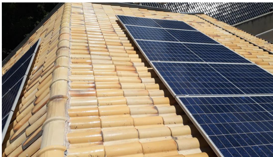
Figura 36 - Módulos instalados na face leste
