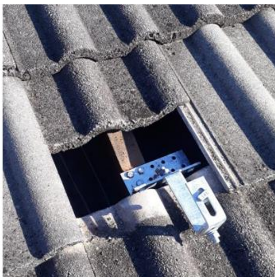
Figura 18 - Suporte para Telhado Colonial
