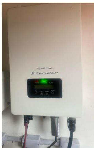
Figura 25 - Inversor CANADIAN CSI-5KTL1P-GI-FL- Sistema 2
