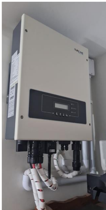
Figura 42 - inversor SOFAR, modelo 5KTML-G2
