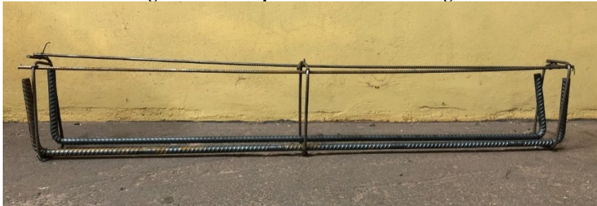
Figura 8 – Exemplo de armadura das vigas.
